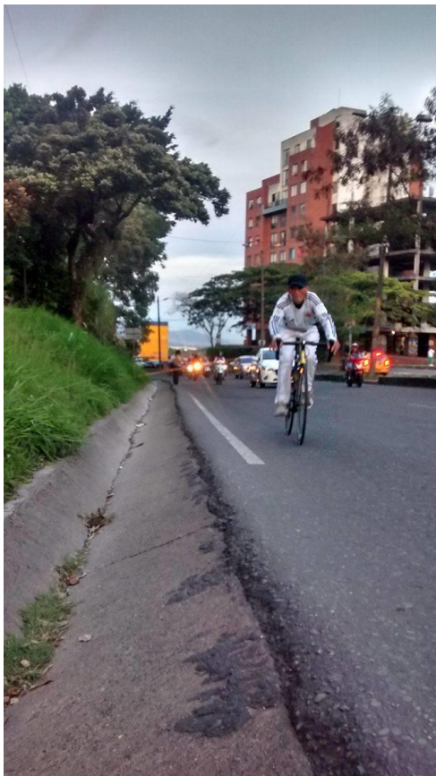
Fig. 6 Ausencia de infraestructura peatonal. Propiedad del autor (2017)
