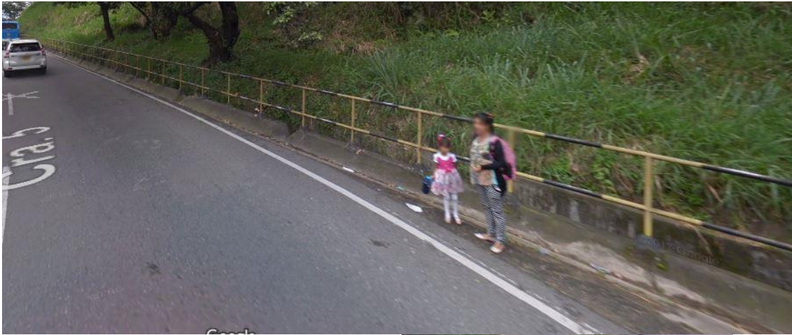
Fig. 5 Falta de infraestructura peatonal. Tomado de Google Maps (2016)
