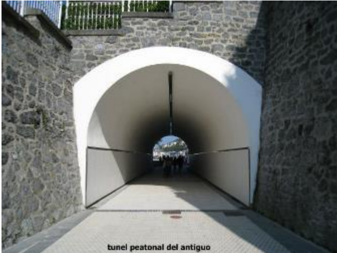
Figura 14: Túnel peatonal del antiguo (Anlopa, 2011)
