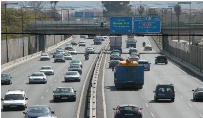
Figura 13: Pasarela peatón (García, 2009)
