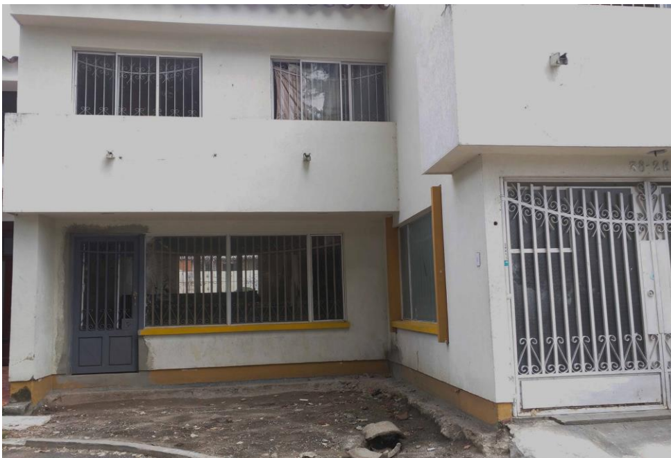
Figura 8. Abandono de viviendas.
