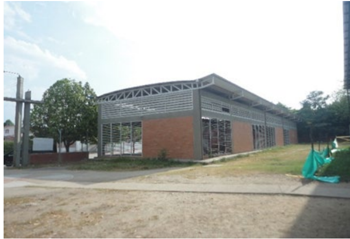
Ilustración 1 Vista general del Terminal de Carmen de Apicalá. Fuente: Propia
