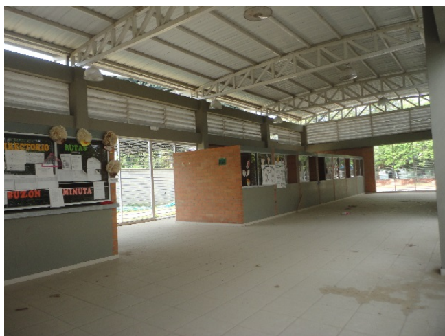
Ilustración 2 Terminal Carmen de Apicalá aspecto interior. Fuente: Propia
