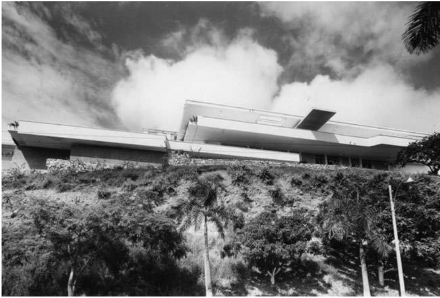
Foto N°1: Casa Feldsberg – Fachada Norte. Fuente: Banco de la República. Santiago de Cali, 2020
