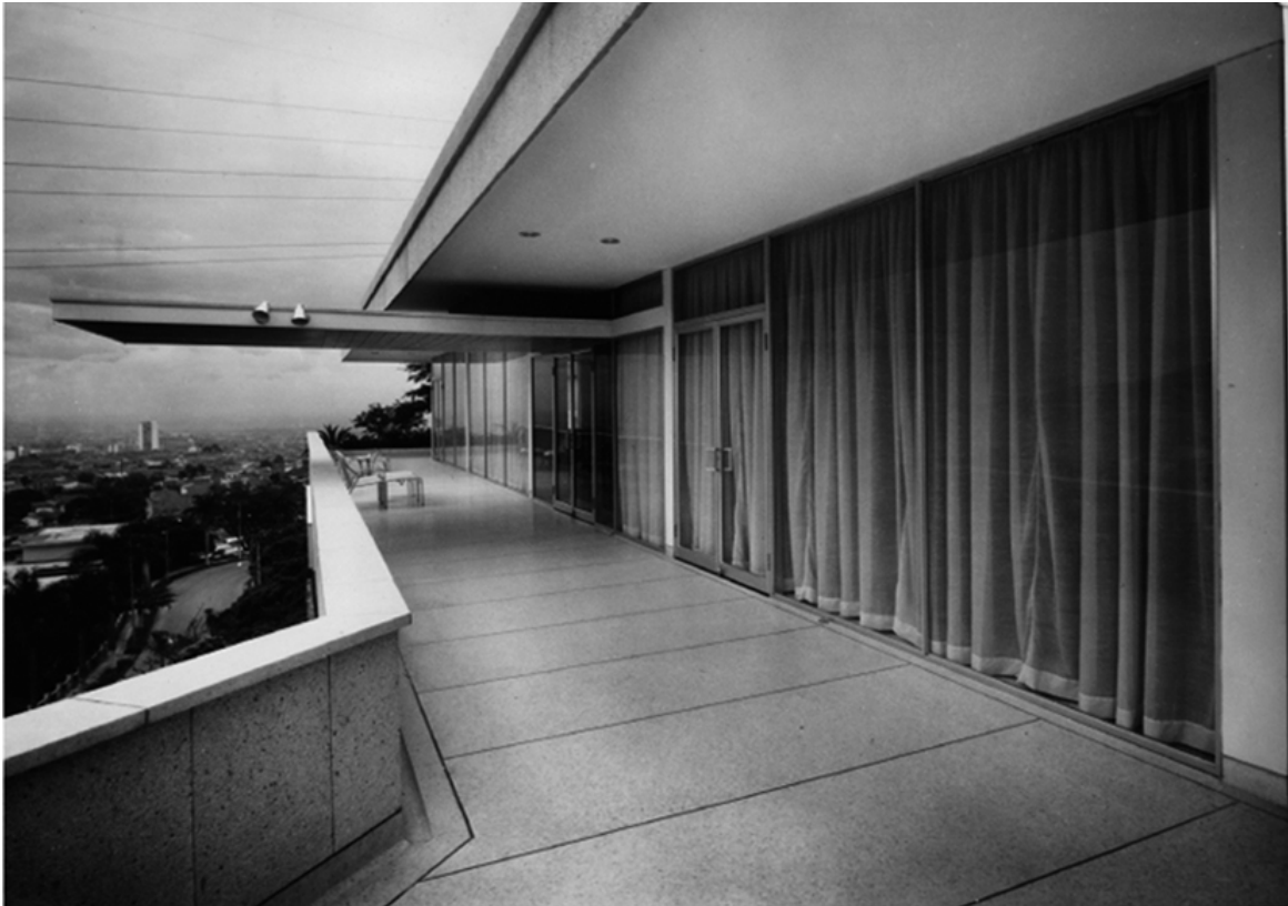
Foto N°6: Casa Feldsberg – Fachada norte. Fuente: Banco de La República. Santiago de Cali, 2020
