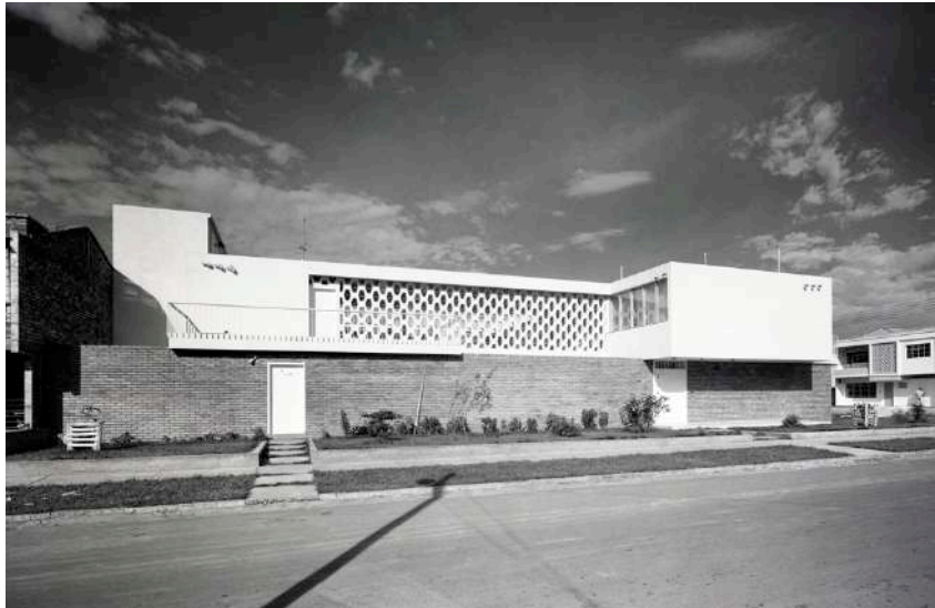
Foto N°8: Casa Cárdenas – Fuente: Banco de la República. Santiago de Cali, 2020
