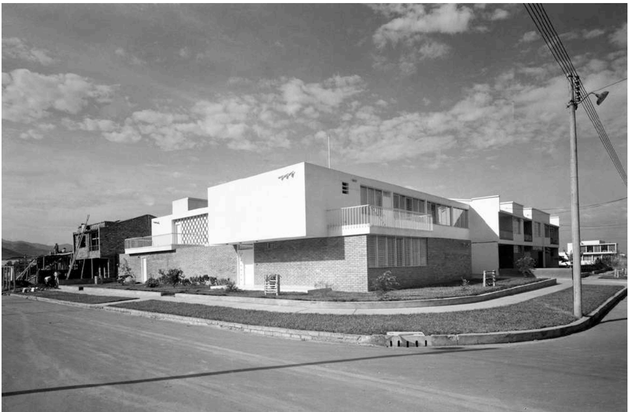
Foto N°3: Casa Cárdenas Fuente: Banco de la República. Santiago de Cali, 2020.
