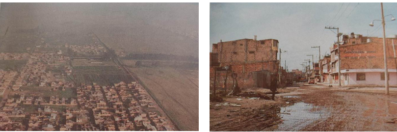
Figura 1 y 2 Empresa de Acueducto y Alcantarillado de Bogotá. HABITAT II. PROYECTO TINTAL CENTRAL UNA OBRA COLECTIVA PARA FORMAR CIUDAD.
